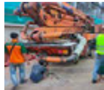
Gambar 3 Contoh waiting di lapangan ( Concrete Pump mengalami trouble sehingga pengecoran tertunda)
