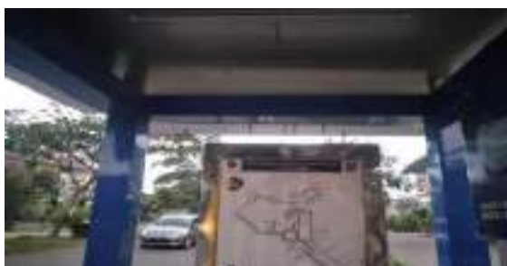
Gambar 26. Halte Villa Bogor Indah 2-1 bagian kanan tanpa CCTV
