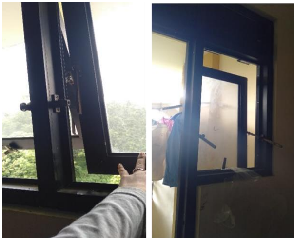
Gambar. 8 Engsel jendela lepas
