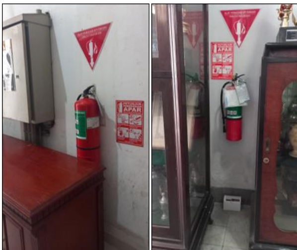
Gambar 4. Peletakan APAR Tertutup Benda
