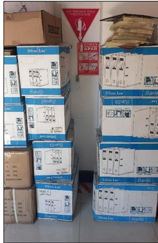
Gambar 5. APAR Tidak Ada Di Lokasi
