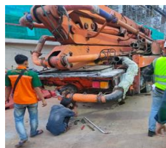
Gambar 3 Contoh waiting di lapangan ( Concrete Pump mengalami trouble sehingga pengecoran tertunda)
