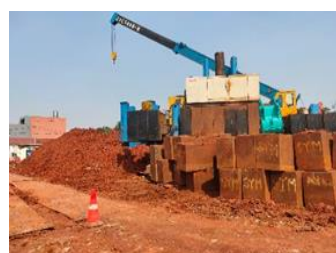
Gambar 4 Contoh waiting di lapangan (Alat HSPD kehabisan material spunpile sehingga pekerjaan pemancangan tertunda)
