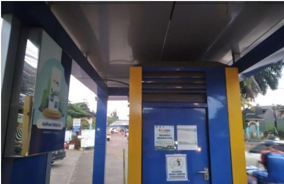
Gambar 27. Halte Villa Bogor Indah 2-1 bagian kiri tanpa CCTV
