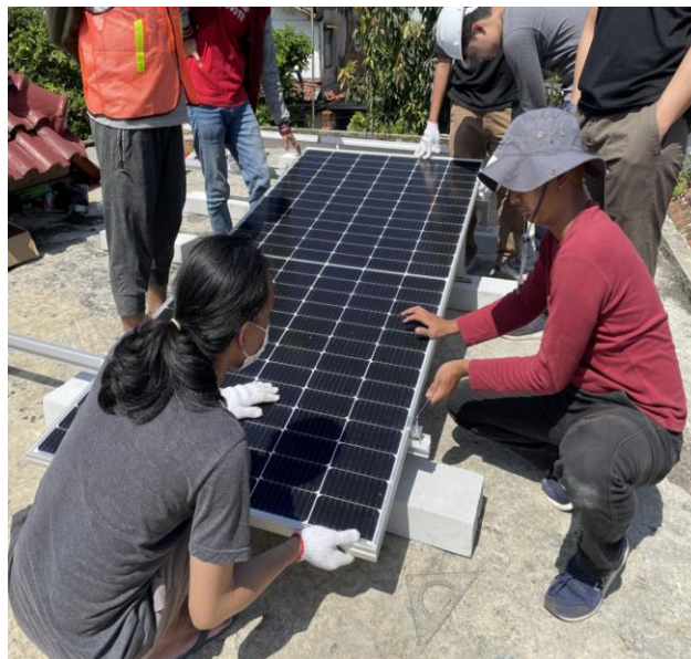
Gambar 3. Proses Instalasi PLTS
